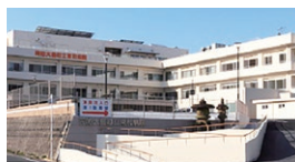
5 周防大島町立東和病院
